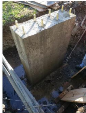
Desencofrado de pedestales.
