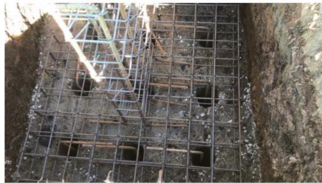
Colocación de armadura.
