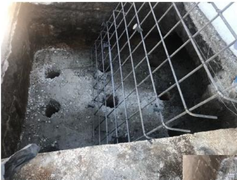
Colocación de armadura.
