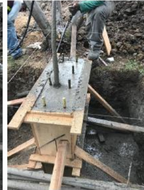
Desencofrado de pedestales.
