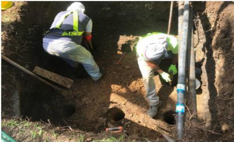
Excavación de Micropilotes.
