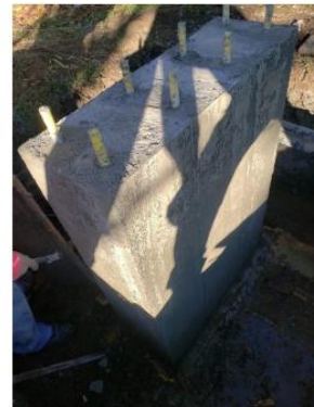
Desencofrado de pedestales.
